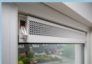
Exemple de grille de ventilation intégrée au châssis
